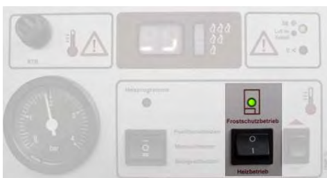
Bild: Bedienfeld Heizungsschalter EIN / AUS
