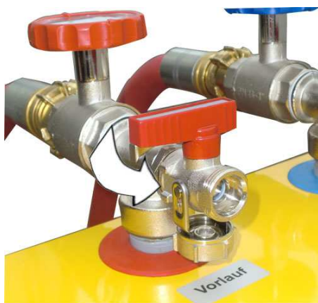
Bild: Kugelhahn der Entlüftungsleitung öffnen
