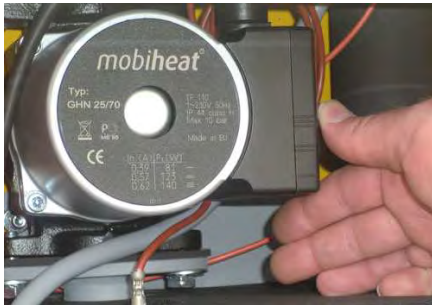
Bild: Pumpendrehzahl umschalten
