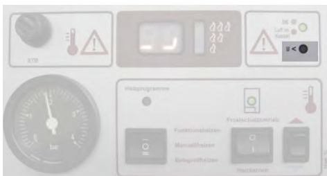
Bild: Bedienfeld LED-Kontroll-Anzeige „U<“
