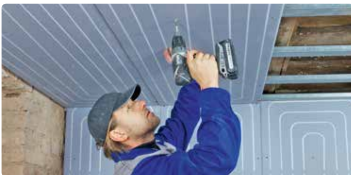
Uponor Renovis Elemente werden einfach mit handelsüblichen Trockenbauschrauben an der Unterkonstruktion befestigt.
