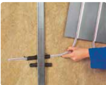
Die Anbindeleitung durchführen
