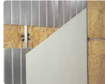
Blick auf die Beplankung
