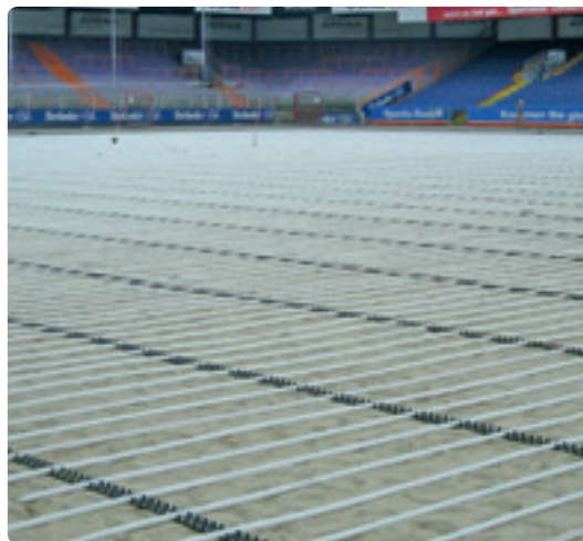
Für den Oberbau fertig verlegte Uponor Rasenheizung.
